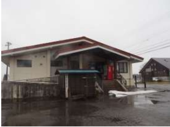
＜サン・スポーツランド管理棟＞
